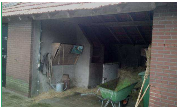
Element 1. (zie figuur 1 blz. 7) Deze schuur is opgetrokken uit stenen muren, gebinten en onbeschoten kap.
