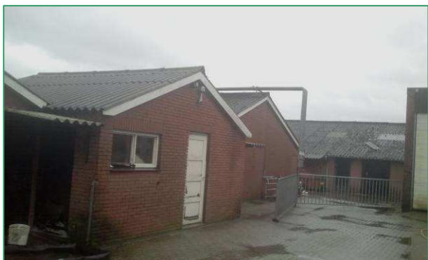
Element 6. Hermetisch afgesloten varkensstallen.
