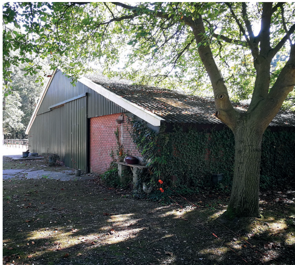
Figuur 7 Foto te slopen opstallen
