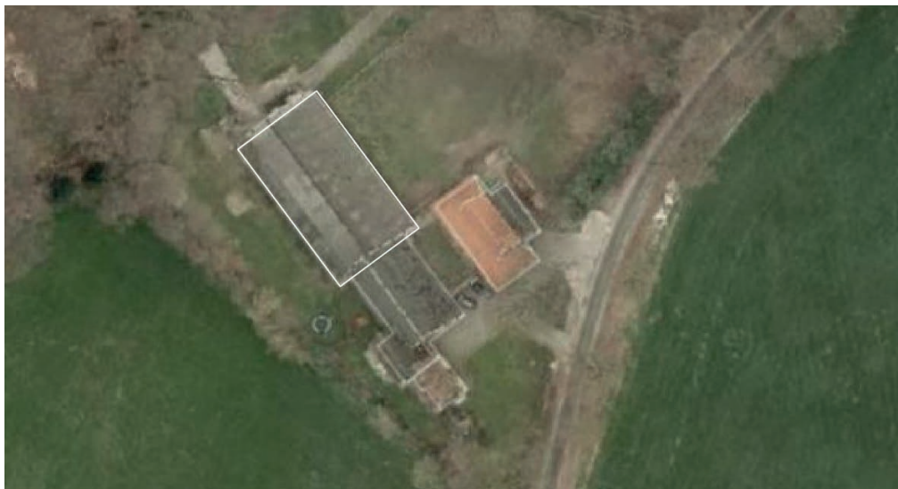
Figuur 6 De te slopen landschapsontsierende gebouwen - Wiekerstraat 5 Rossum
