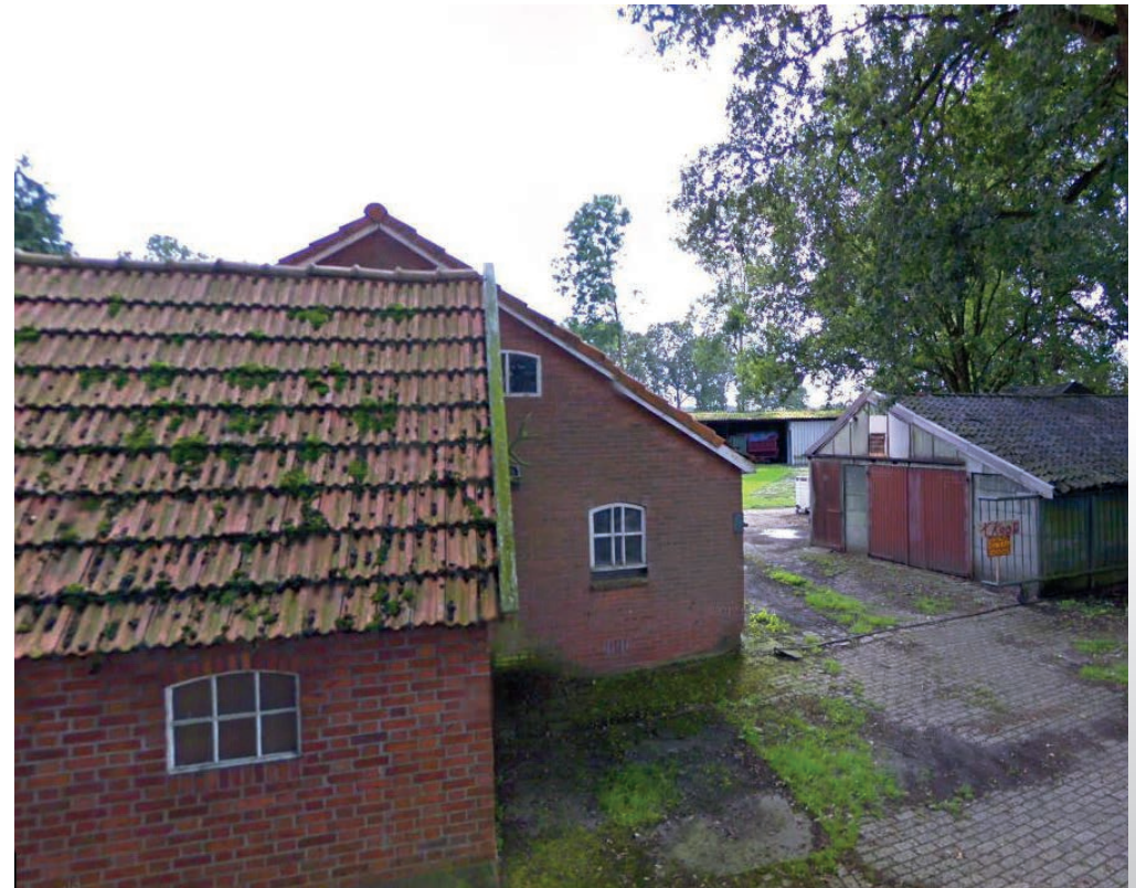
Figuur 3 Foto van de te slopen opstallen
