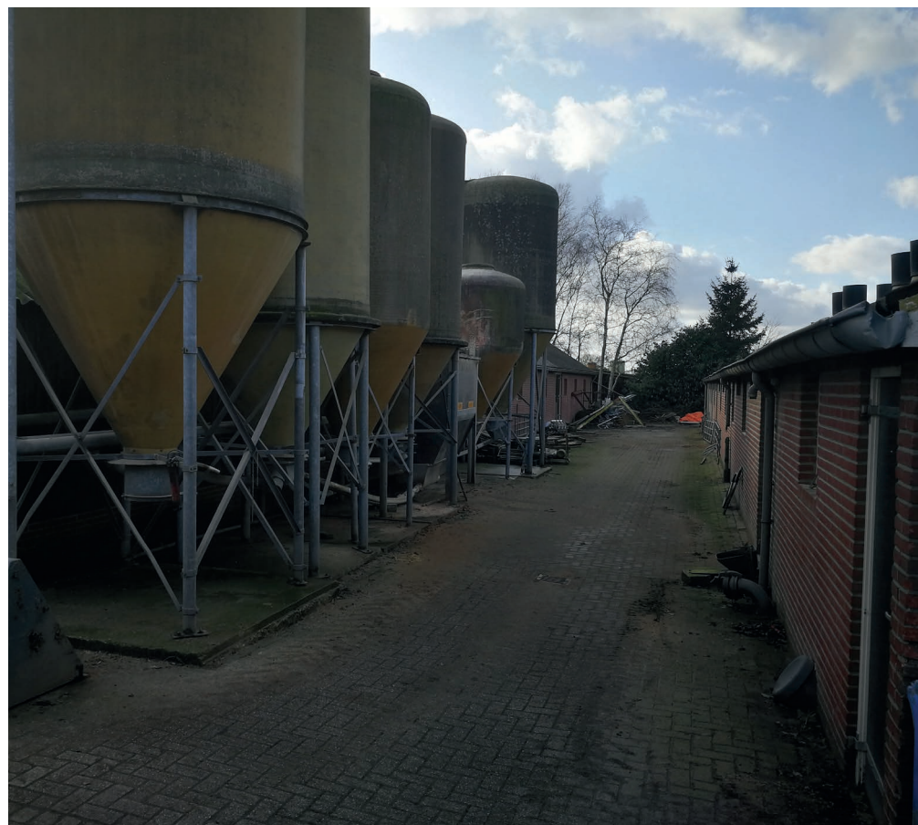
Figuur 5 Foto van de te slopen opstallen
