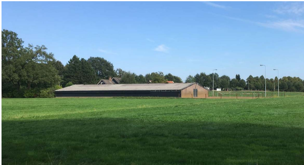
Figuur 3 De te verwijderen schuur - Ootmarsumsestraat 43
