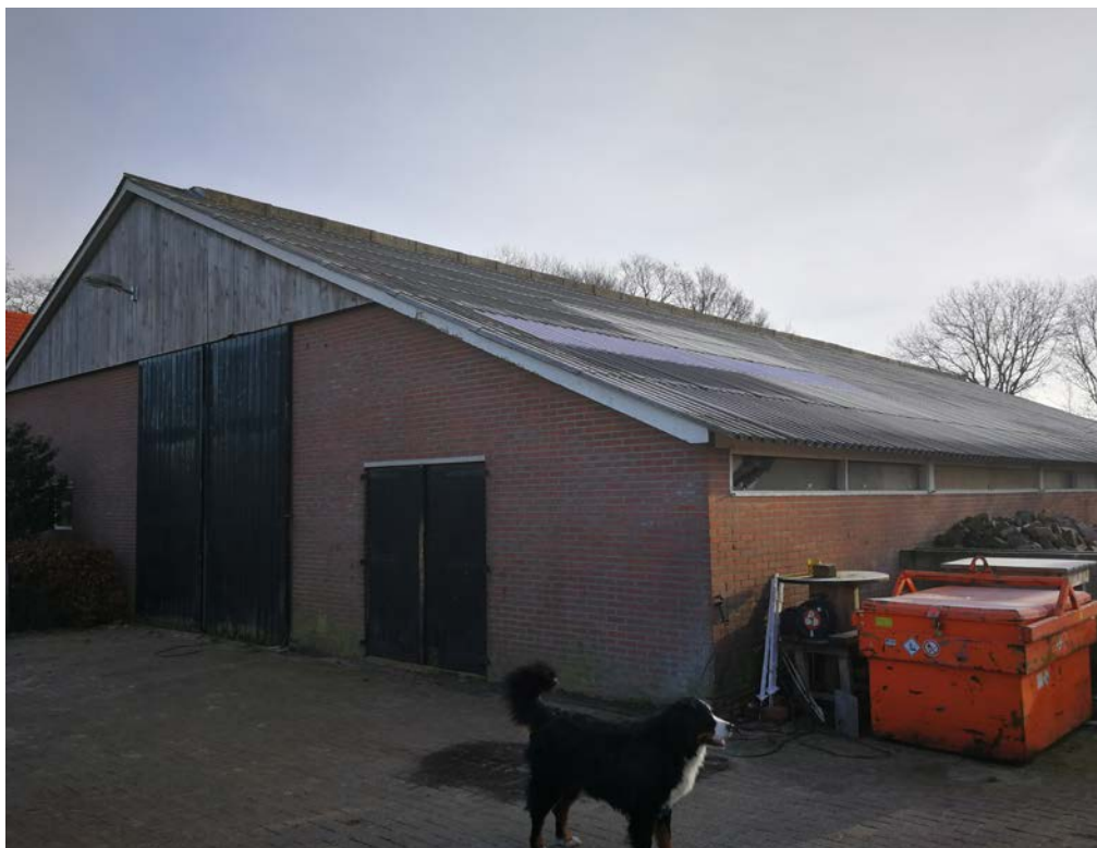
Figuur 6 De te verwijderen schuur - Westerhoekweg 10
