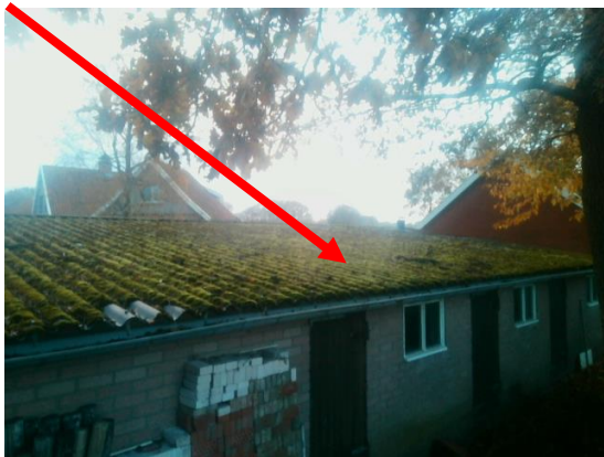
Foto 3 | Golfplaten op het dak
