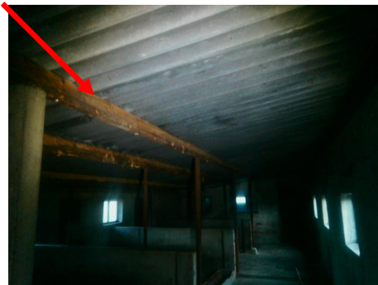
Foto 4 | Golfplaten op het dak
