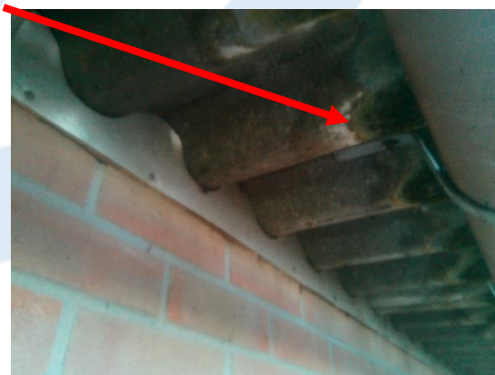
Foto 2 | Golfplaten op het dak
