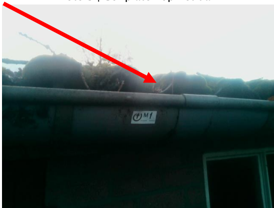
Foto 5 | Golfplaten op het dak
