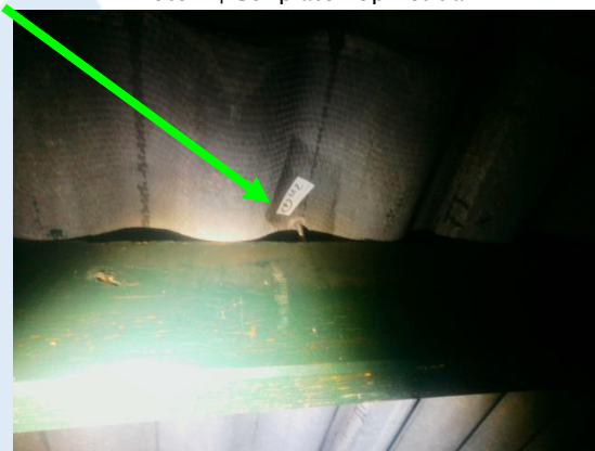
Foto 6 | Golfplaten op het dak
