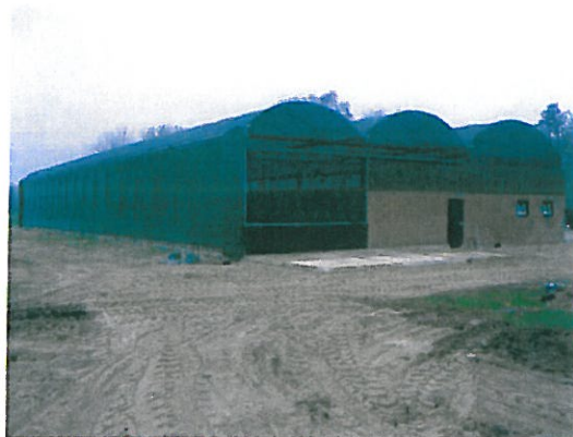
Technische installaties in de stal oplossen
