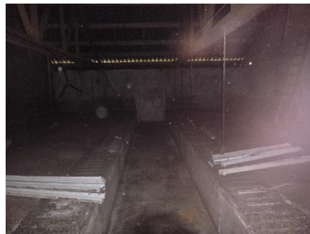
Te slopen schuur binnen
