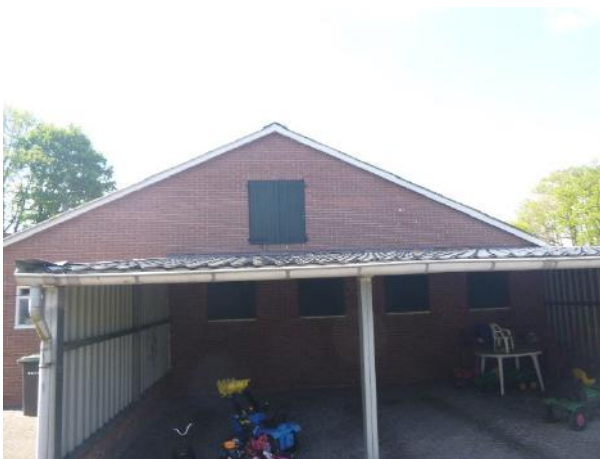
Te slopen overkapping
