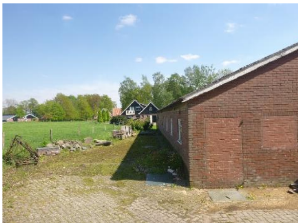
Noordzijde te slopen schuur
