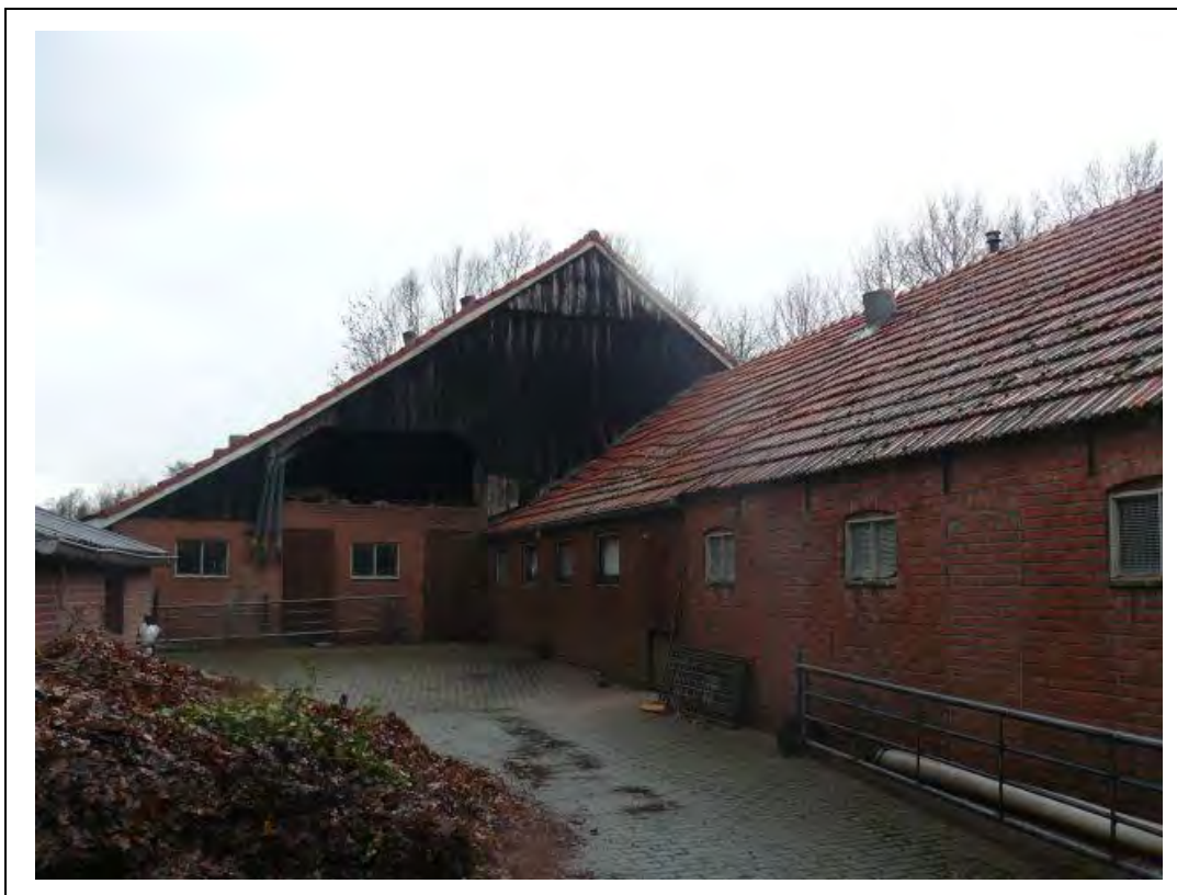
Foto 2. Voormalige openkap schuur met zolderruimte.
