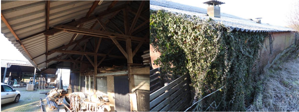
Impressie van de te slopen bebouwing.
