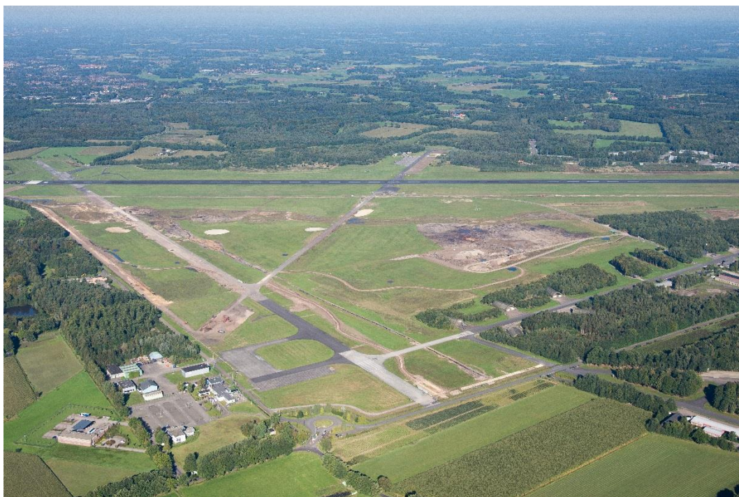
Afbeelding 1. Luchtfoto Vliegveld Twente vanuit zuidoostelijke richting (Eelerwoude / Rayflight, oktober 2015).
