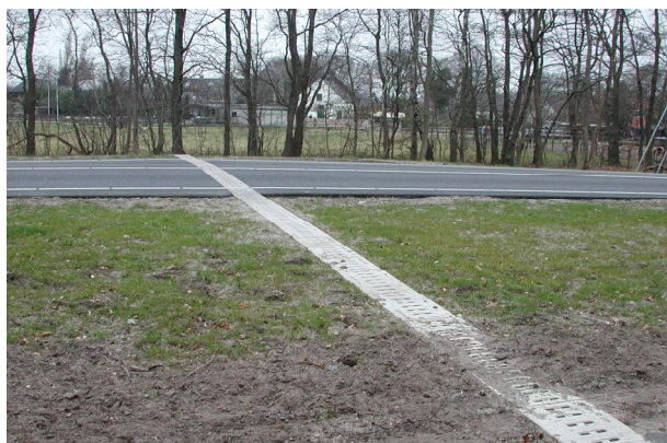
Foto's 6 en 7. Paddentunnel. (Boven: opening met keerwand. Onder : goot door weg)
