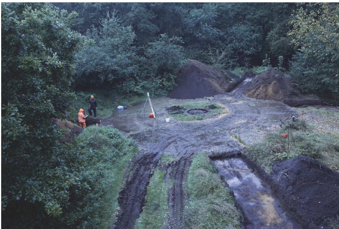
Afbeelding 3.1 | Sfeeropname tijdens de werkzaamheden.
