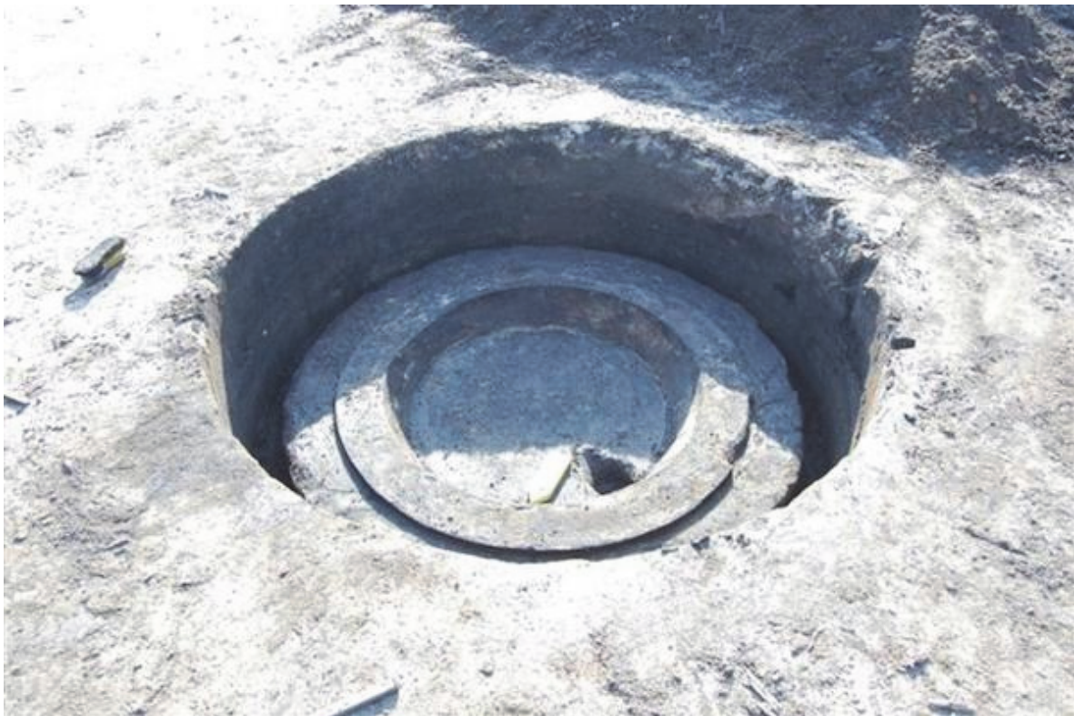
Afbeelding 5.4 | Het aslager van de compenseerschijf te Sint-Denijs-Westrem ( luchtvaarterfgoed.be ).
