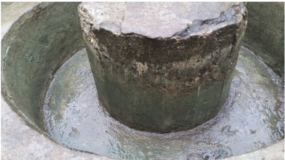
Afbeelding 5.8 | Detail van het schoongemaakte aslager. Het centrale deel heeft duidelijk een veelhoekige wand als gevolg van de bekisting of mal waarin het beton is gegoten.
