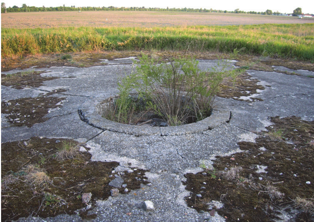
Afbeelding 5.5 | De compenseerschijf van Flugfeld Aspern ( flugfeld-aspern.info ).
