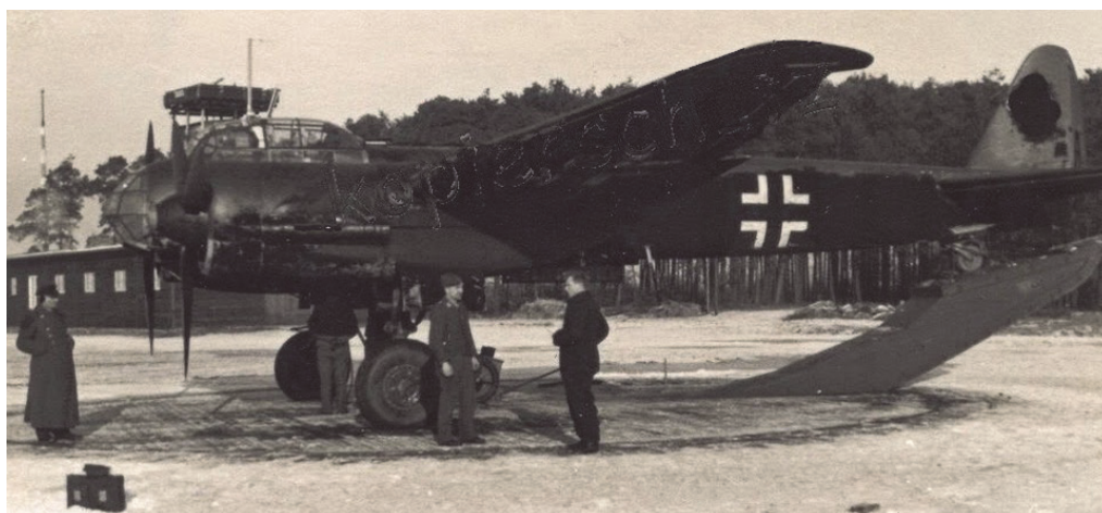
Afbeelding 2.6 | Een Junkers Ju 88 A op een compenseerschijf op de Duitse vliegbasis Bad Zwickhahn. Op deze foto is het stelmechanisme onder het staartwiel duidelijk zichtbaar (falkeins.blogspot.com).
