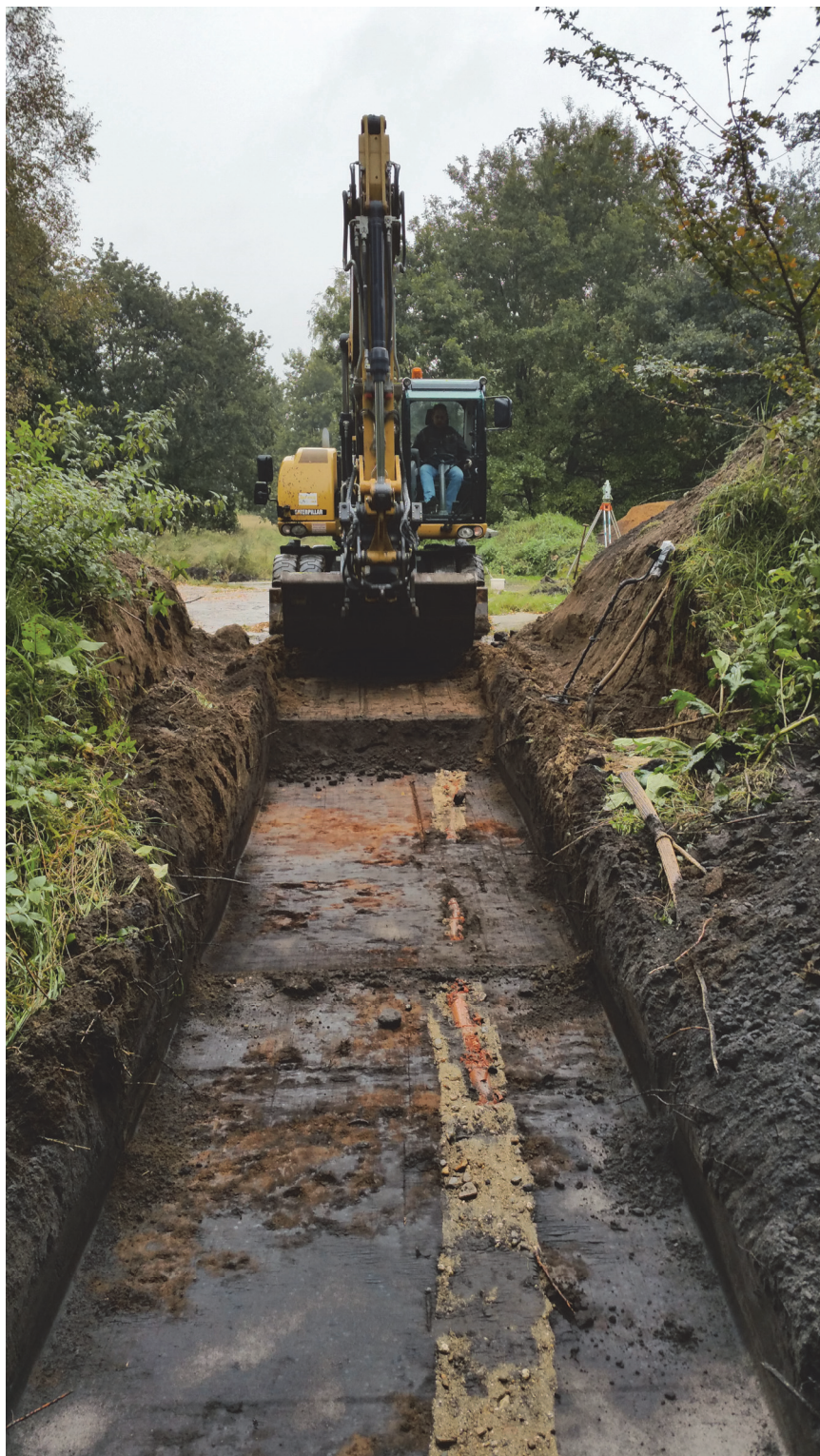
Afbeelding 3.2 | De aanleg van het vlak in werkput 3 met een drainagesleuf die parallel aan de sleuf loopt.
