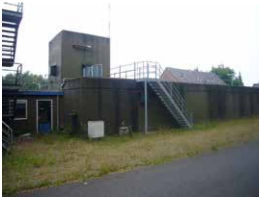
Bunkers van de commandopost Centrum.
