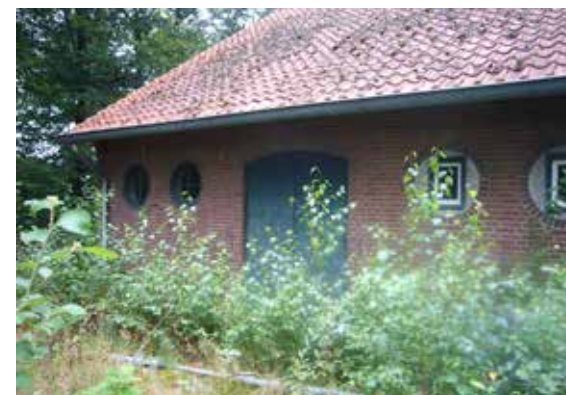
Camouflage architectuur, gevel met stalramen en deeldeuren de stalramen zitten te hoog en de deeldeuren zijn slechts façade, daarachter zit een betonnen muur.
