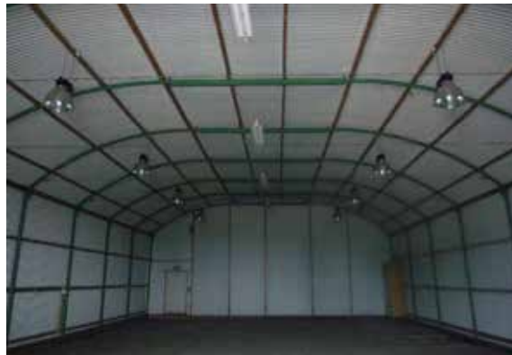
Vm. Oostkamp: Romney-loods als kleine hangar: interieur.
