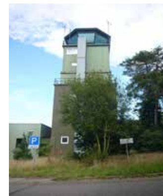
De verkeerstoren werd met een staalconstructie verhoogd.
