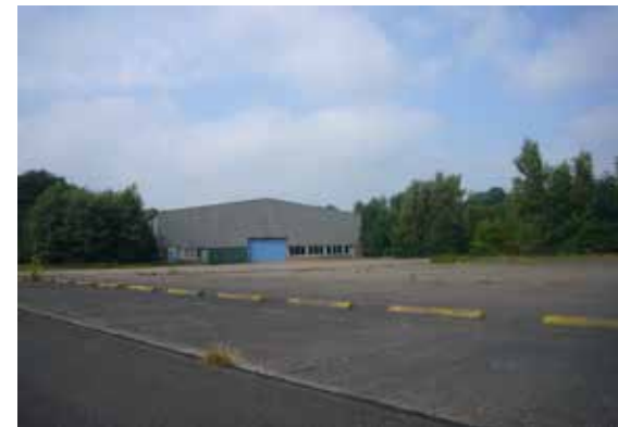
Hangar ringweg westzijde.
