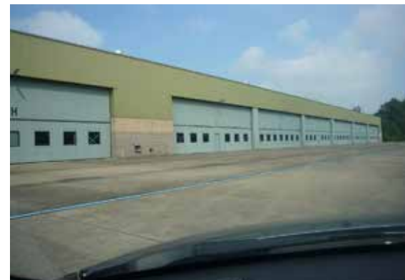
Grote hangar in cluster westzijde.
