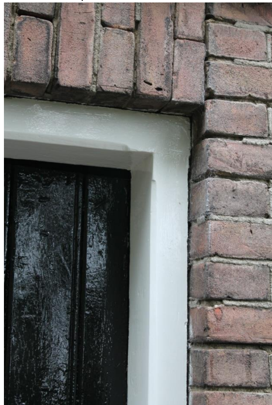
Geprofileerd deurkozijn rechter zijgevel
