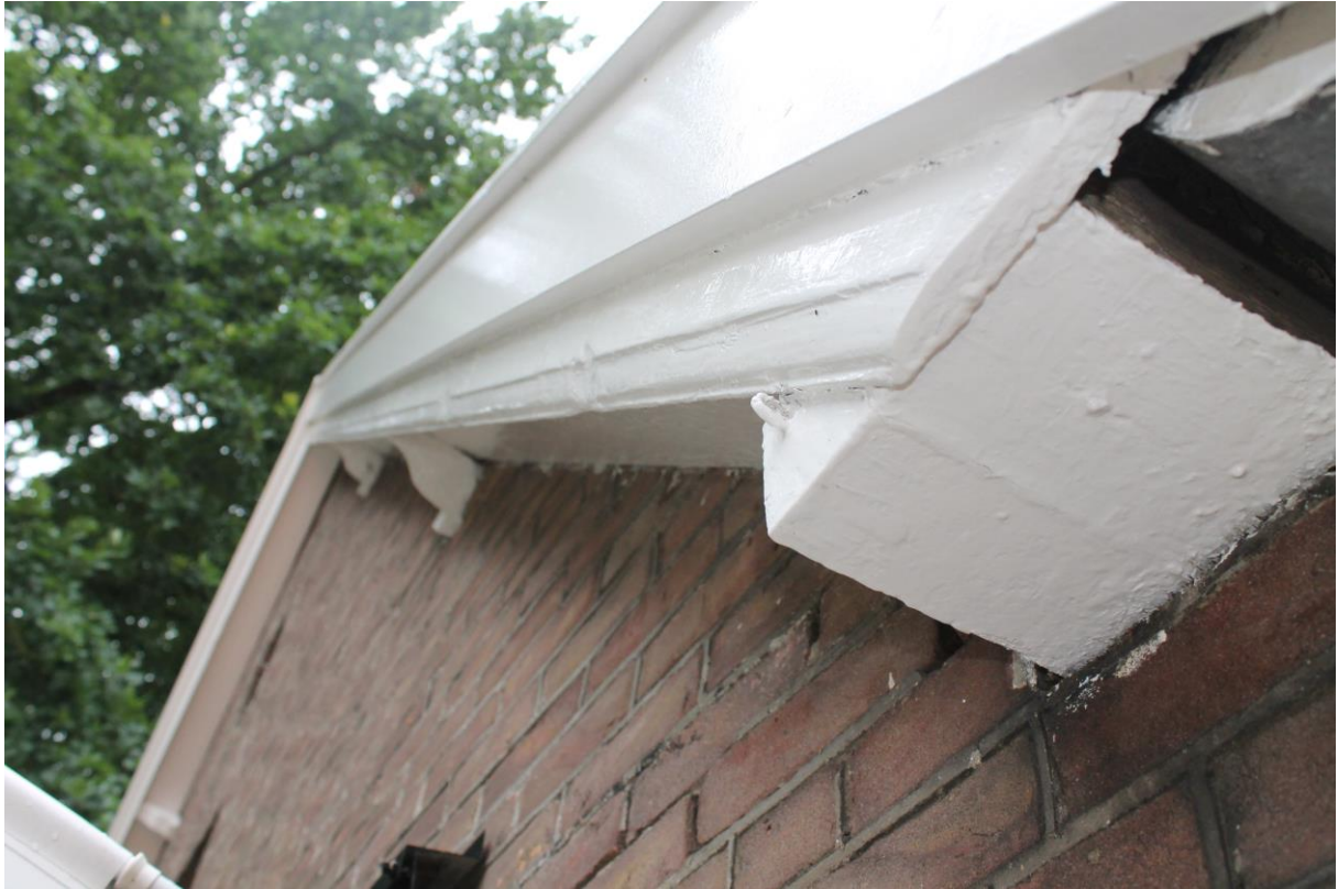
Geprofileerde windveer met gordingklossen
