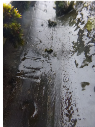
NT-golfplaten op dak
