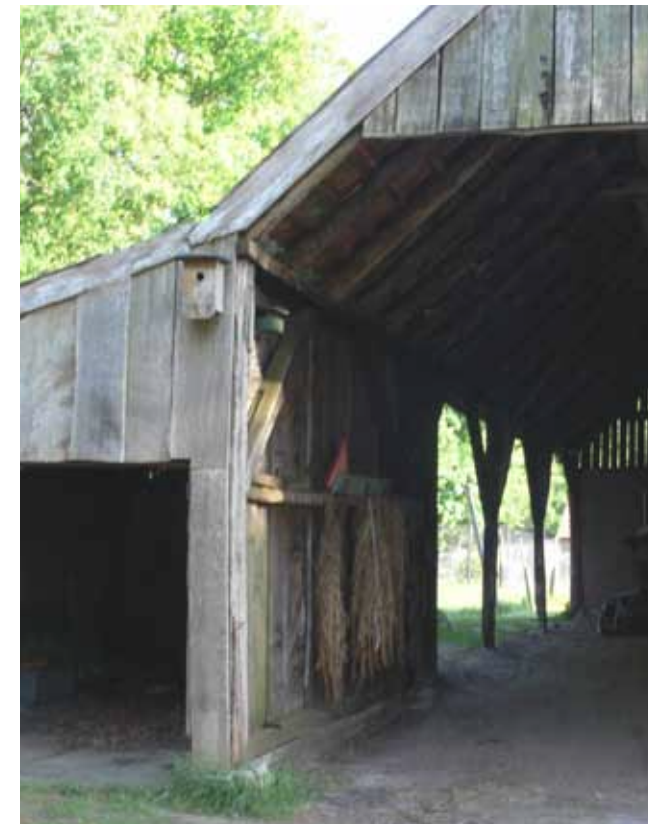
Bestaande kapschuur en aanbouw.
