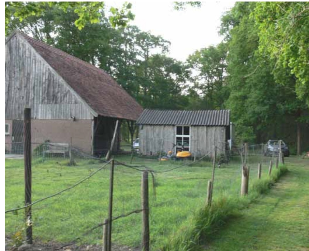
Bestaande schuur met kleine bijgebouwen.
