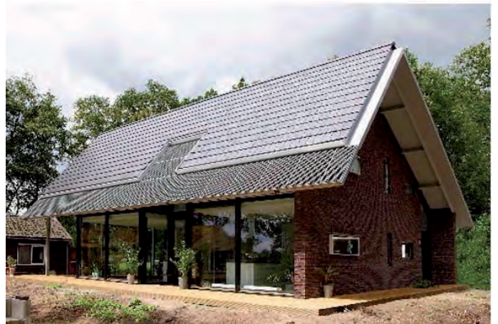
Schuurvorm met grote hoge ramen voor zicht
