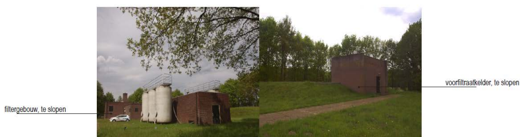
Afbeelding 3.6: Te slopen bebouwing.
