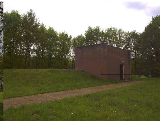
voorfilteraatkelder, te slopen
