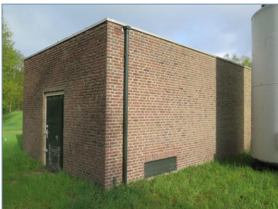
Foto 3. Gebouw zonder geschikte en/of toegankelijke verblijfruimten voor vleermuizen.
