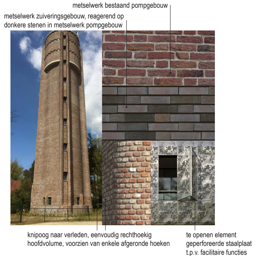
materialisering zuiverings- en onthardingsinstallatie
