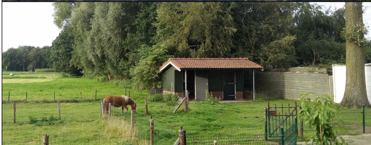
Afbeelding 2.4 Beelden van de bestaande gebouwen
