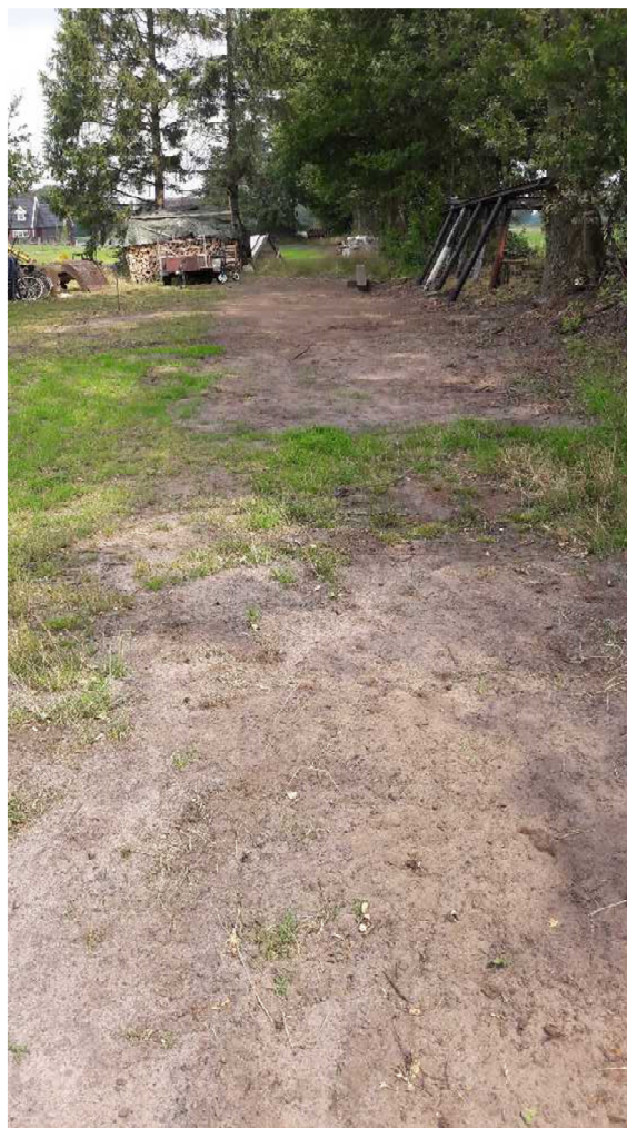
Onverharde weg met sporen puin op het maaiveld
