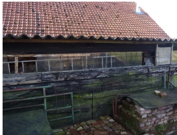
Druppelzone en opslag bouw materiaal
