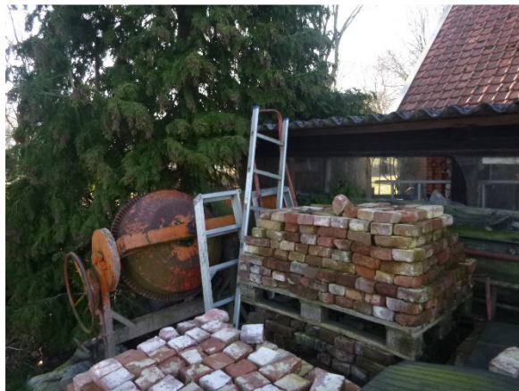
Druppelzone en opslag bouw materiaal
