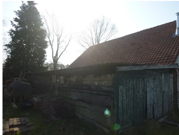
Overkapping noordzijde schuur
