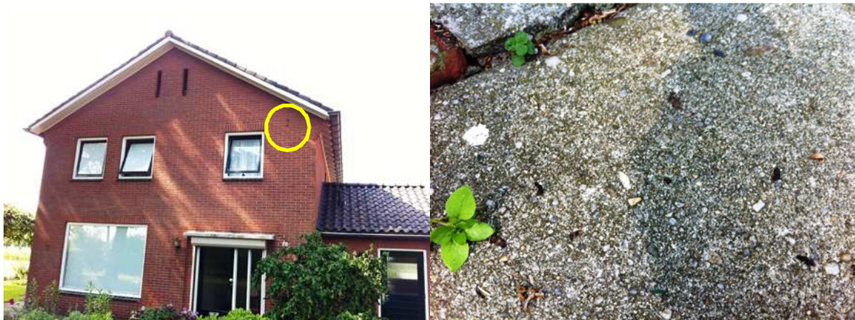
Mogelijke invliegopening voor vleermuizen aan de te slopen woning (links). Rechts; uitwerpselen van vleermuizen onder de gevel van de te behouden schuur.
