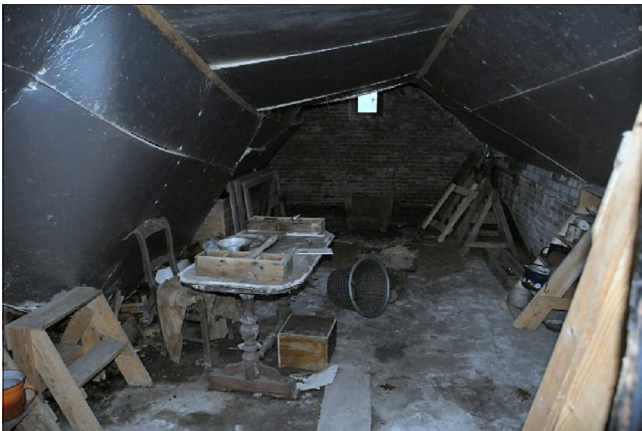
Afbeelding 5. Halfondergrondse opstal met sporen van bewoning.
