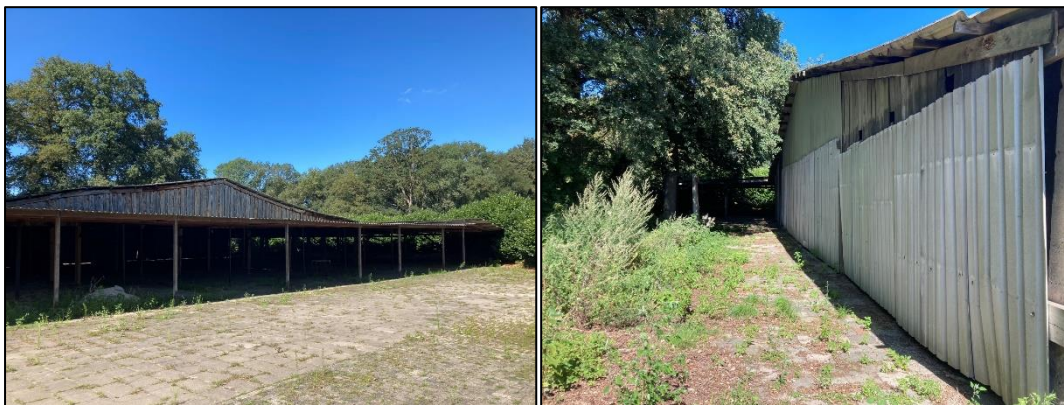
Figuur 2.3 (links): De noordwestelijke grote overkapping is aan drie zijden open; Figuur 2.4 (rechts): De achterkant van de overkapping, hier is de overkapping afgesloten met damwand/golfplaat. Er is een strook tussen de bosschade en de overkapping leeggehouden en betegeld.
