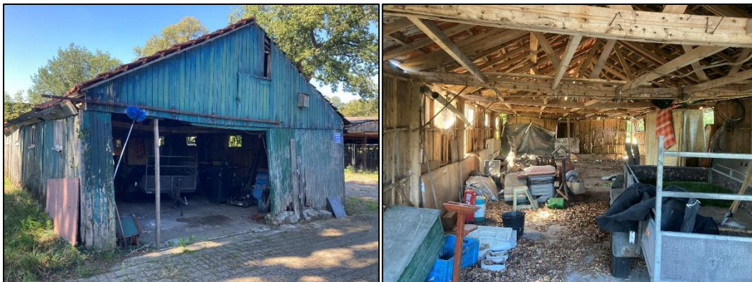
Figuur 2.12 (links): Het derde bijgebouw, een redelijk grote schuur met een aanhanger en wat andere spullen. Er liggen dakpannen op het dak, maar hier is geen dakisolatie aanwezig; Figuur 2.13 (rechts): De binnenkant van het derde bijgebouw.
