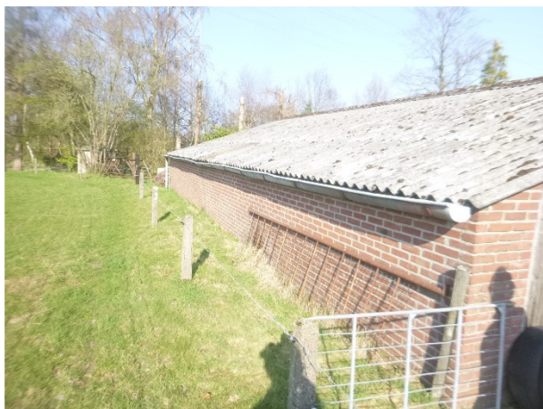
Dakgoot westzijde schuur
