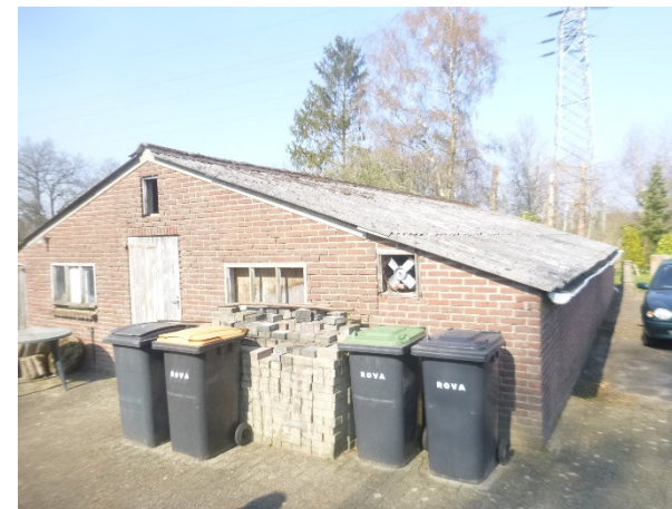
Opslag klinkers zuidzijde schuur.
