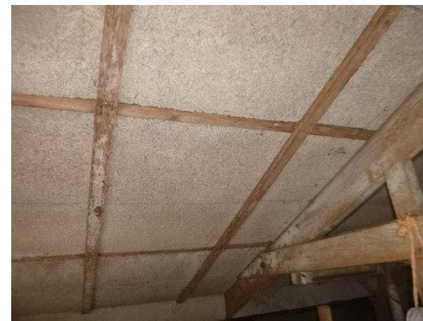
Aftimmering dak binnenzijde schuur
