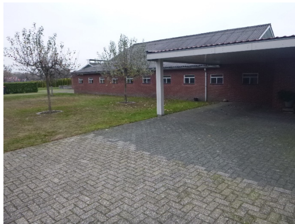
Overkapping en ligboxenstal
