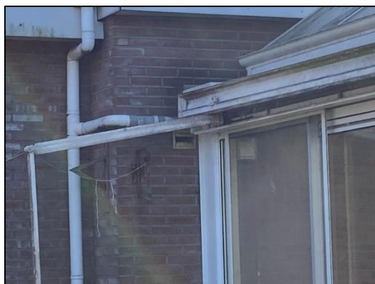
Figuur 6.5: Open ventilatieschacht in het plangebied.
