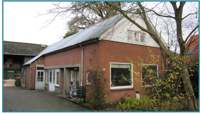
Bestaande (in te passen) houtstructuren nabij plangebied
