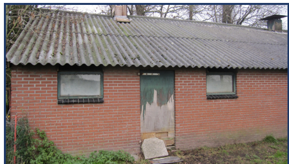
Indicatie bouwtechnische staat varkensschuren
