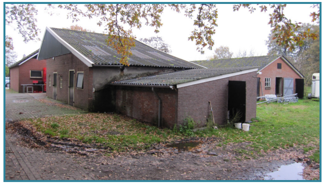
Aanzicht veestalling (25 m2) achter kapschuur, gezien vanaf Tipweg
