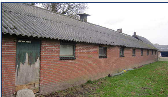
Zijaanzicht te slopen varkensschuren
