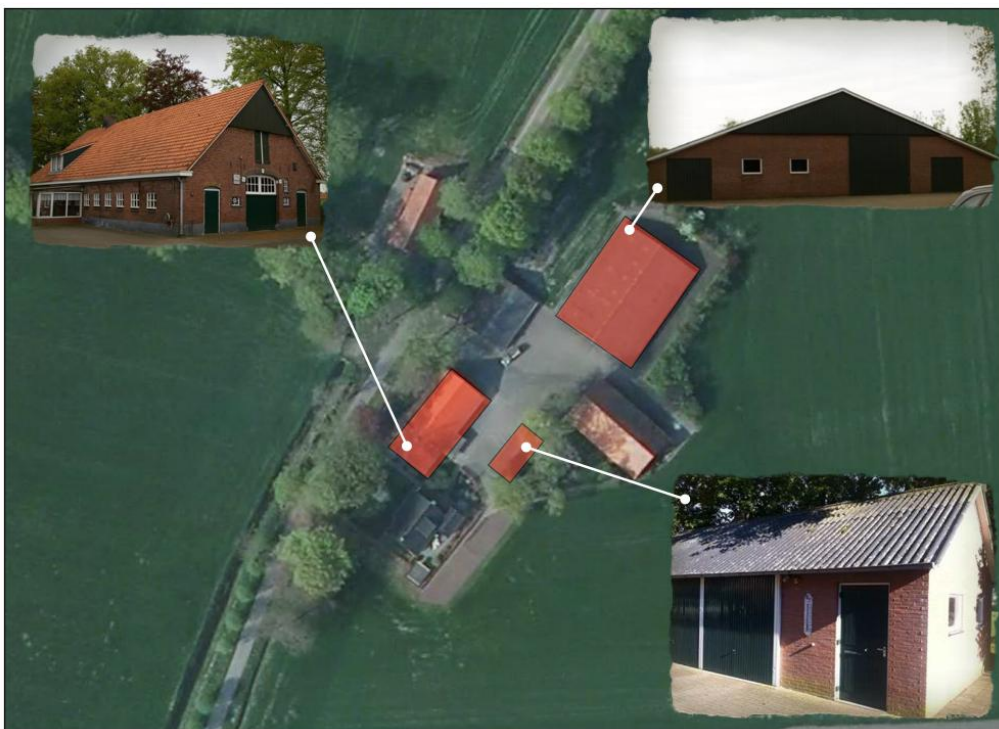
Afbeelding 3.1: te slopen bebouwing op het erf (Bron: BJZ.nu)
