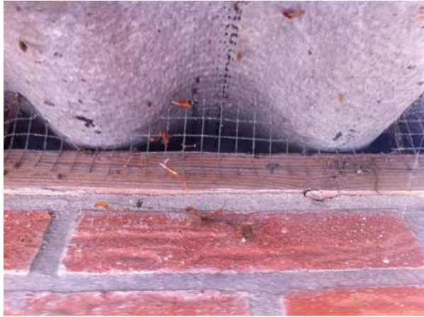
Met gaas is de toegangen tot de holle ruimte tussen golfplaat en dakisolatie afgesloten voor vogels en zoogdieren.
