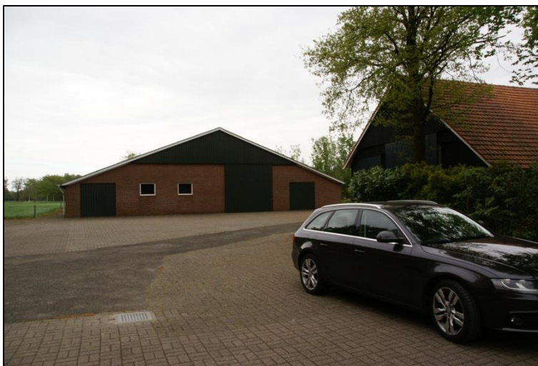
Figuur 4 Te slopen schuur (locatie nieuwbouw) en (rechts) te behouden bijgebouw
