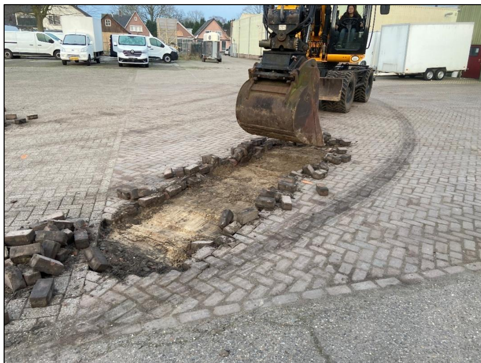
Figuur 3. Verwijderen van de klinkers voorafgaand aan de aanleg van werkput 1 (foto richting het noorden).
