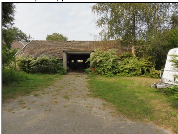
Zicht op de oostzijde van te slopen kippenstal
