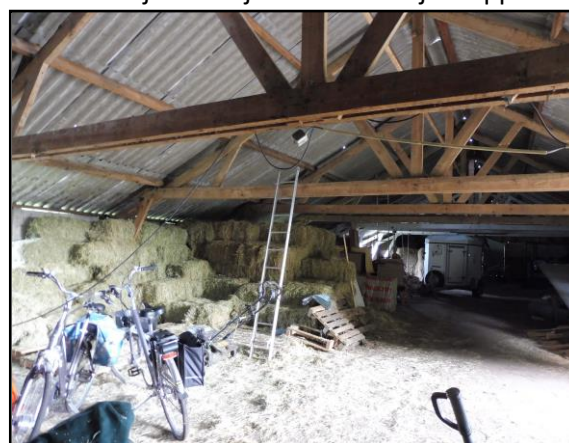
De binnenzijde van de te slopen kippenstal
