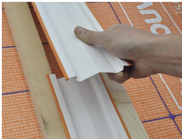
Optioneel leverbaar Reno Naadprofiel voor een waterdichte aansluiting
