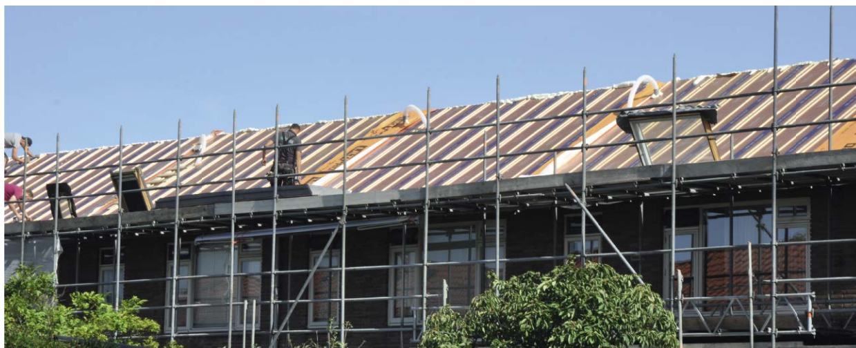
Toepassing horizontale SlimFix® RenoGoot
