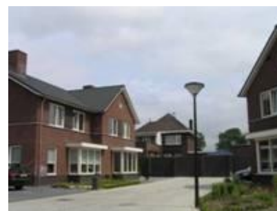
Woningbouw aan de Nieuwenpolder
