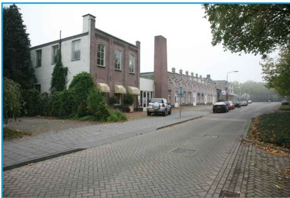
Figuur zicht op plangebied vanaf Parallelweg
