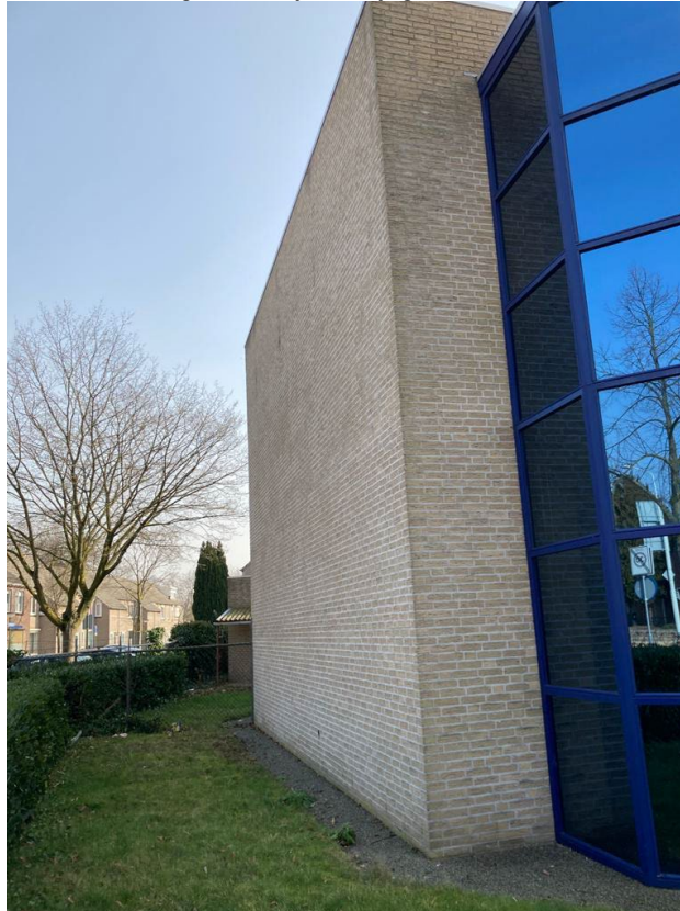
• Afbeelding 3: buitenzijde bedrijfsgebouw
