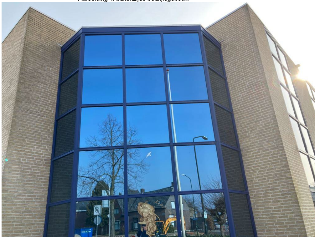
• Afbeelding 4: buitenzijde bedrijfsgebouw
