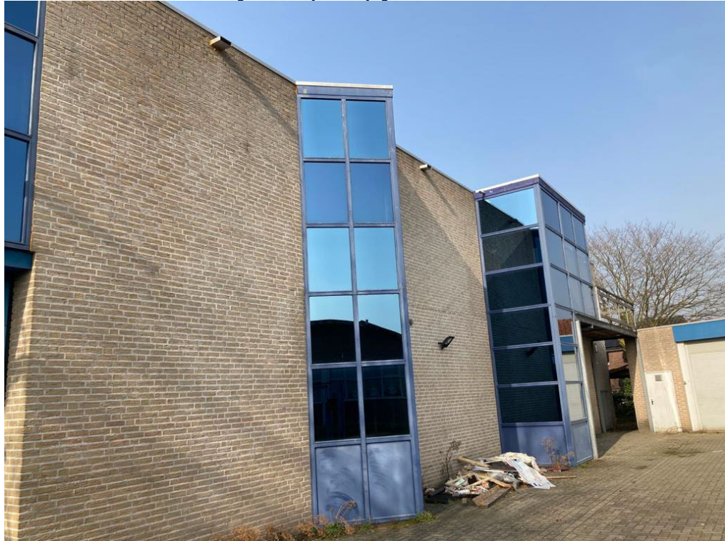
• Afbeelding 6: buitenzijde bedrijfsgebouw
