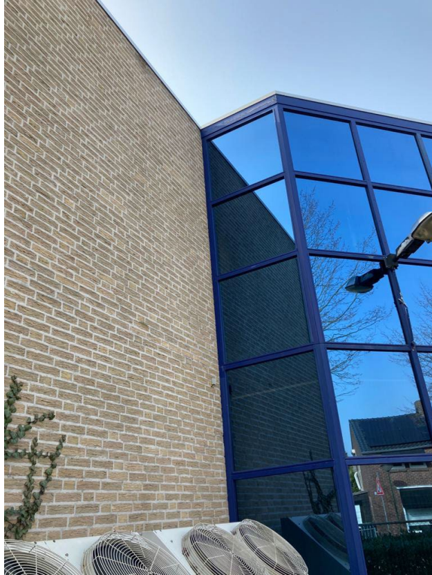
• Afbeelding 8: buitenzijde bedrijfsgebouw
