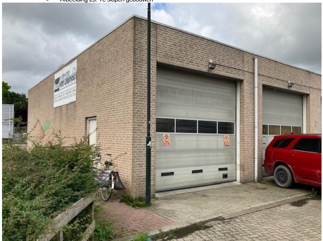
• Afbeelding 25: Te slopen gebouwen
