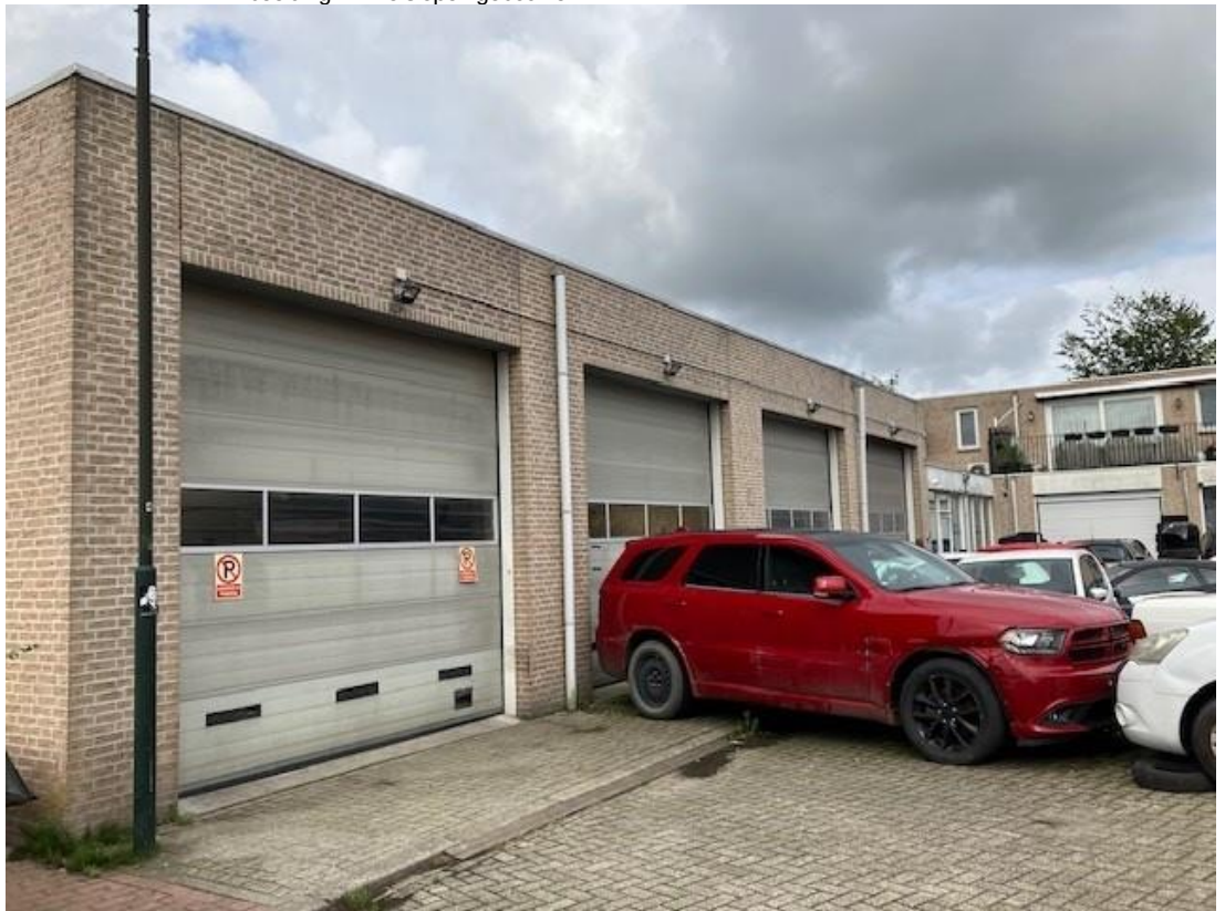
• Afbeelding 24: Te slopen gebouwen
