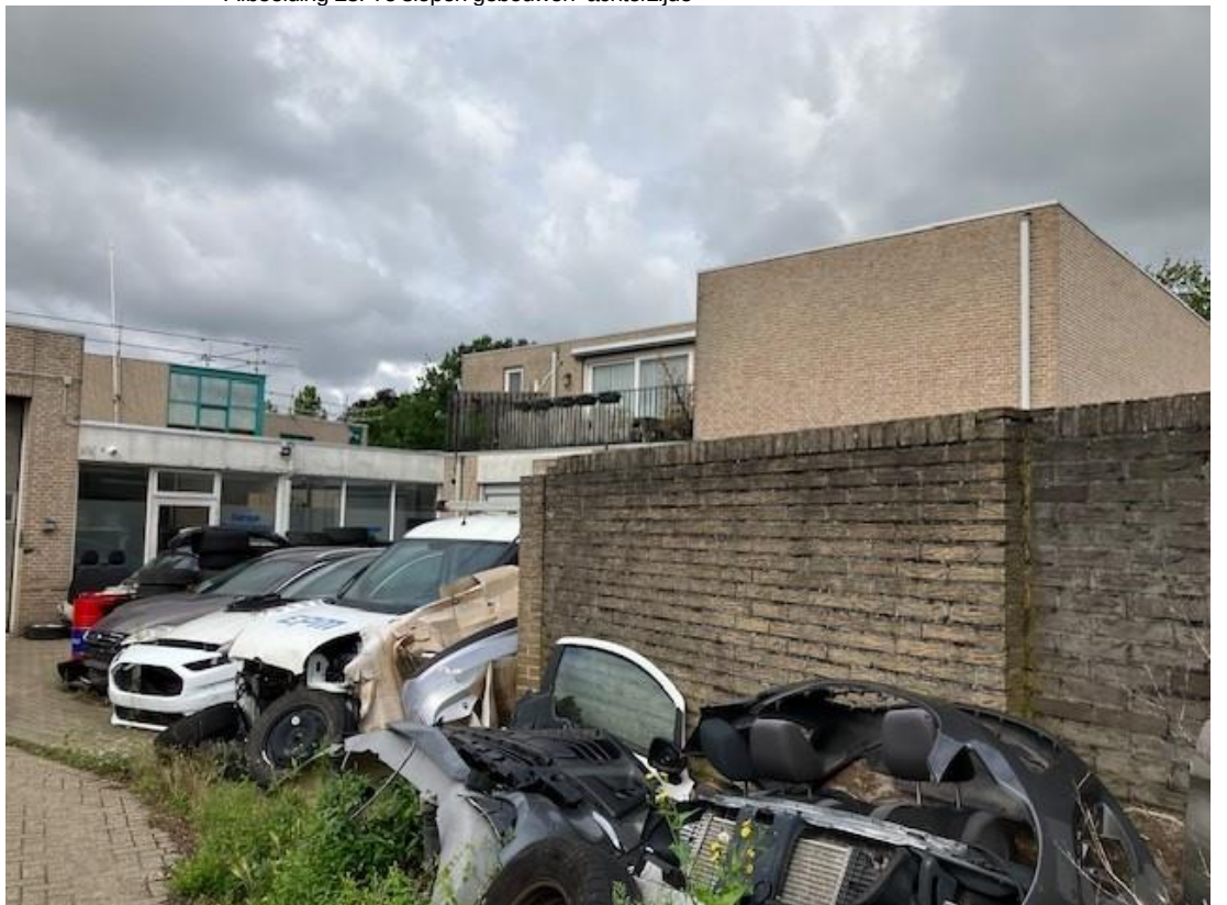
• Afbeelding 23: Te slopen gebouwen achterzijde
