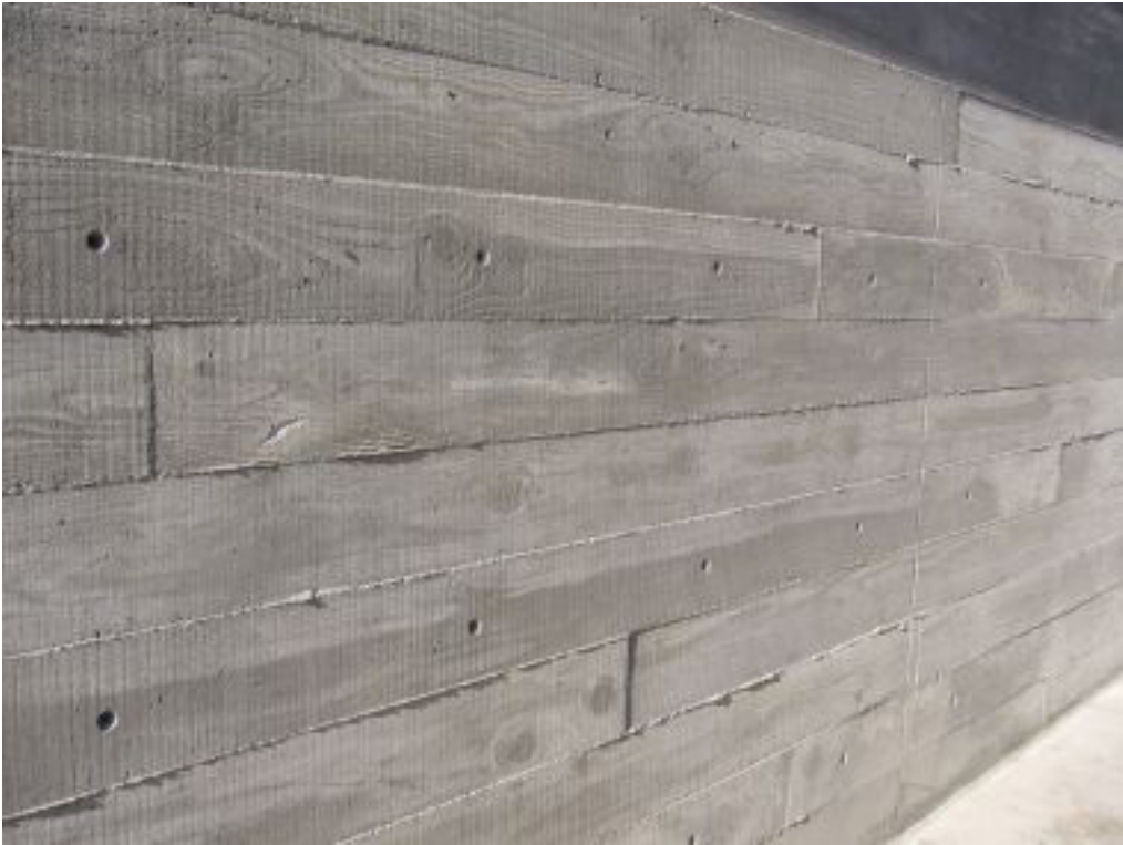
BETON NATUREL UIT PLANKEN BEKISTING
