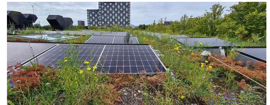
Figuur 44: Groendak (kruidendak) met zonnepanelen
