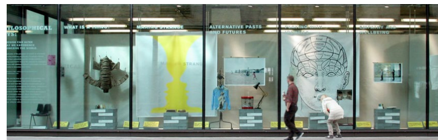
Figuur 35: Transparante gevel met atelier en werkruimten in plint
