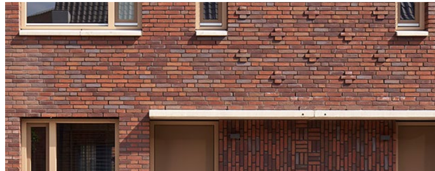
Figuur 18: Hoogwaardig metselwerk en fijne details zorgen voor plasticiteit
