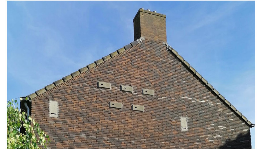
Figuur 41: Ingemetselde nestkasten voor vleermuizen en vogels
