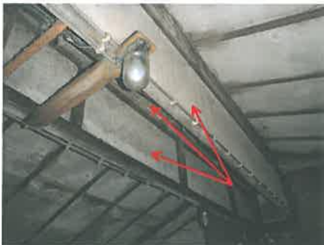
Foto nr. 19: Vlakke plaat
