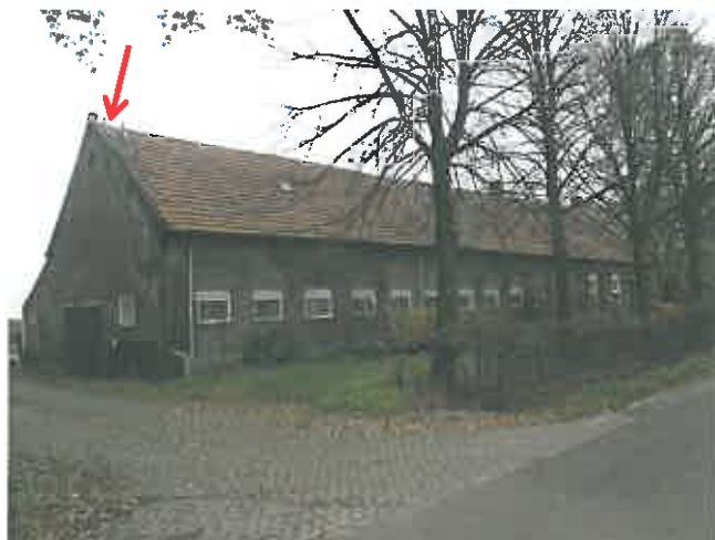
Foto nr. 13: Vlakke plaat
