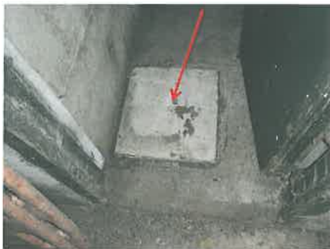
Foto nr. 27: Vlakke plaat
