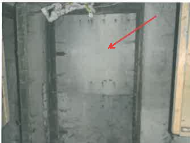
Foto nr. 28: Vlakke plaat
