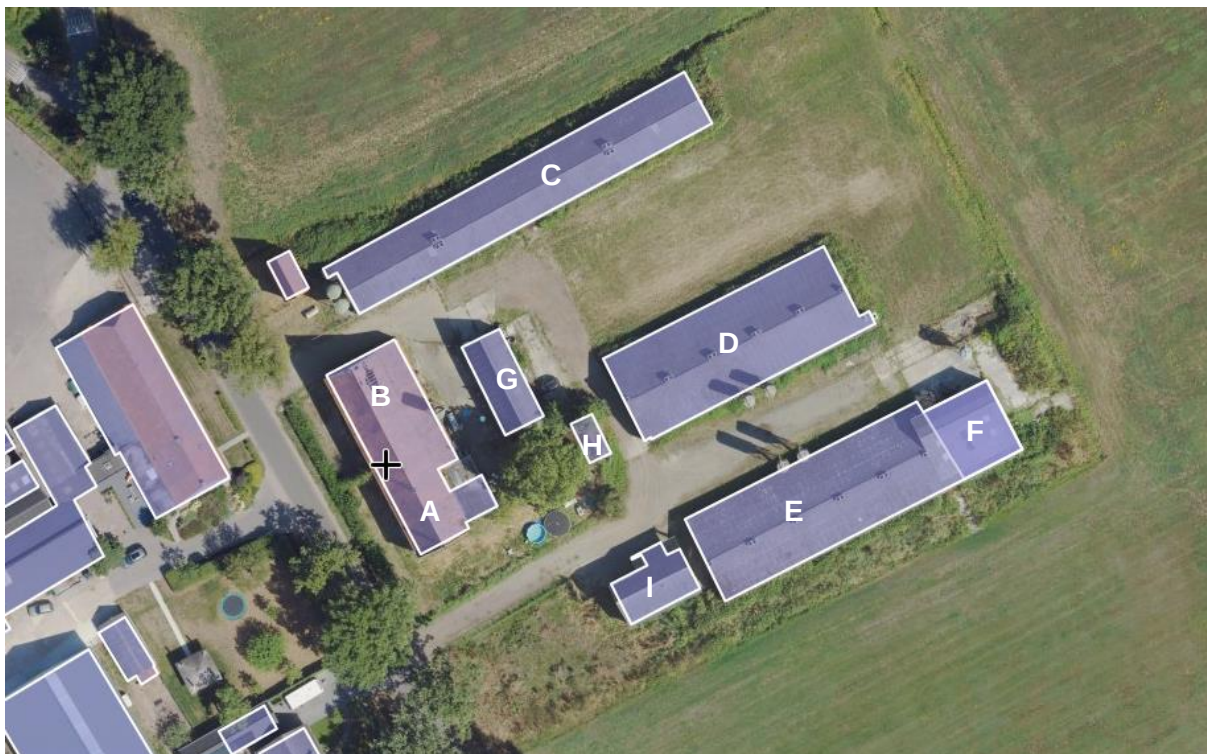
Te saneren bebouwing Broekstraat 58 (bron: streetsmart.cyclomedia.com).
