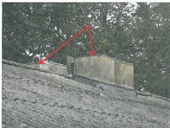
Foto nr. 18: Vlakke plaat
