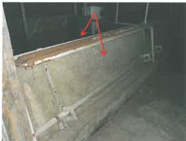
Foto nr. 33: Vlakke plaat
