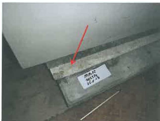
Foto nr. 3: Vlakke plaat
