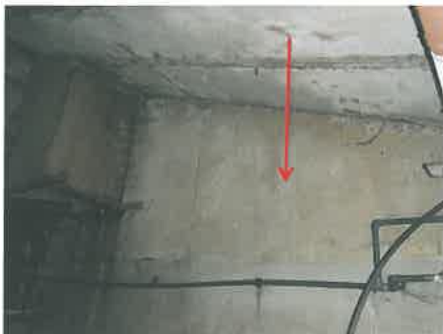
Foto nr. 20: Vlakke plaat
