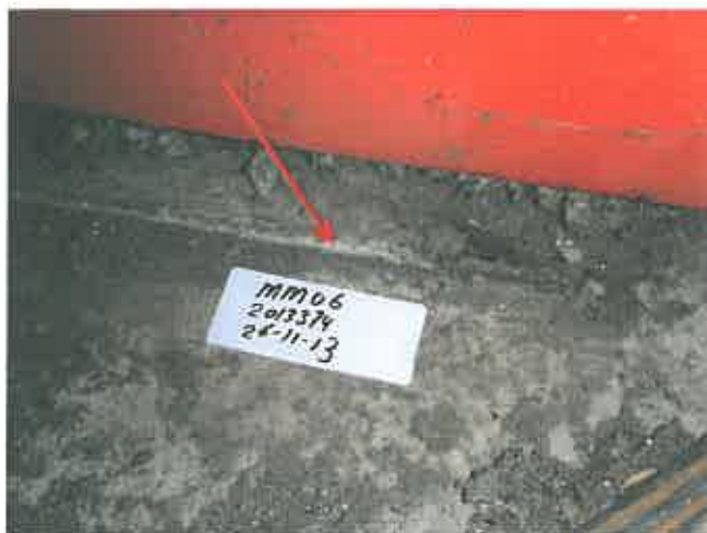
Foto nr. 14: Vlakke plaat
