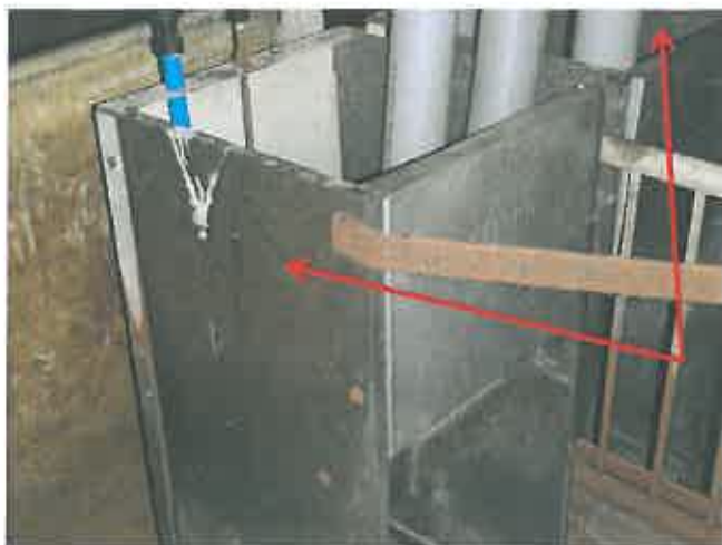
Foto nr. 34: Vlakke plaat
