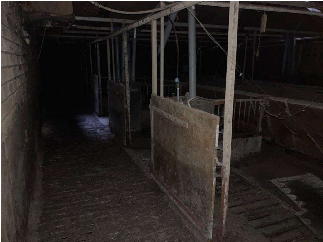
• Afbeelding 19: Binnenzijde voormalig bedrijfsgebouw
