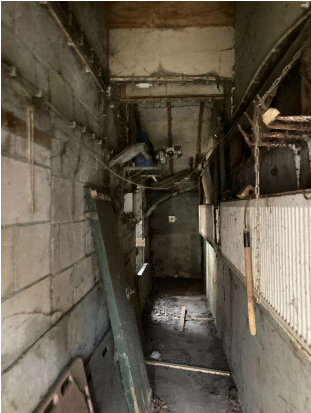
• Afbeelding 21: Binnenzijde voormalig bedrijfsgebouw
