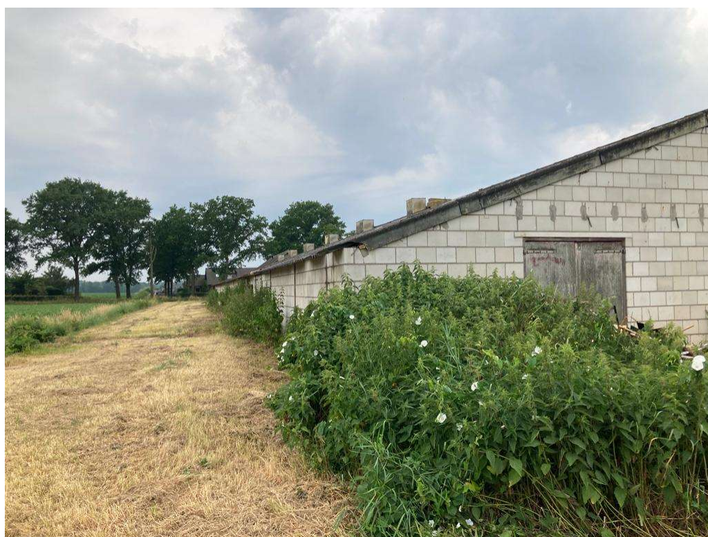
• Afbeelding 8: Achterzijde kapschuur en stal 3, gemaaid gras en overwoekerende brandnetel
