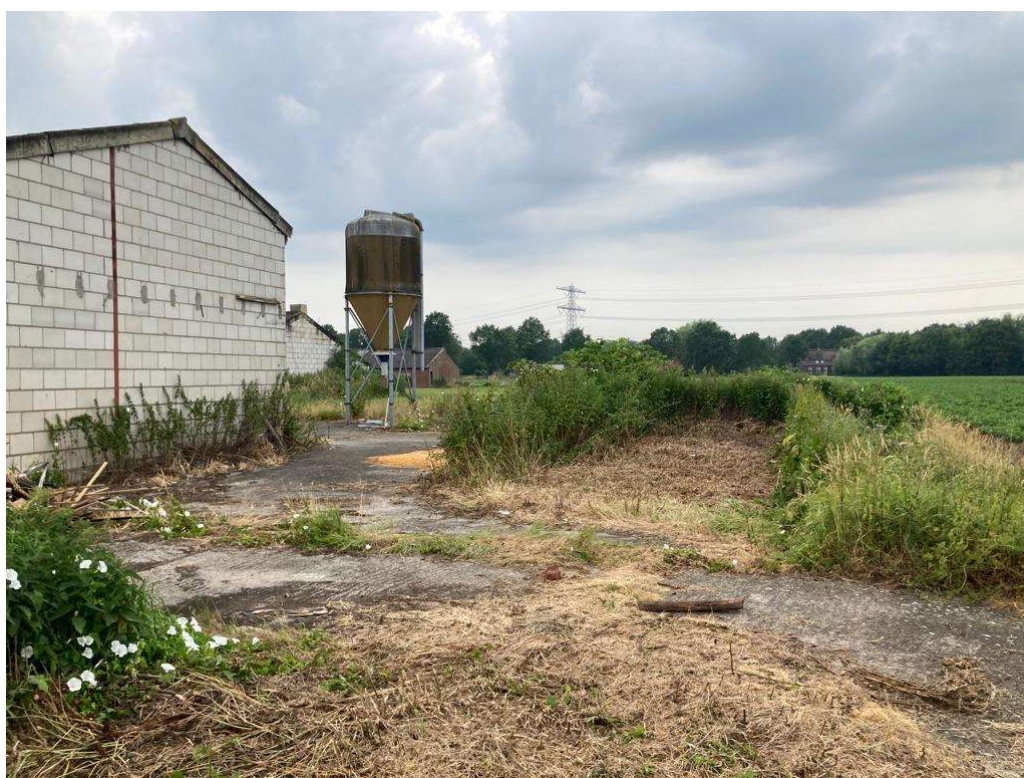
• Afbeelding 12: Achterzijde kapschuur met verharding en kuilplaat
