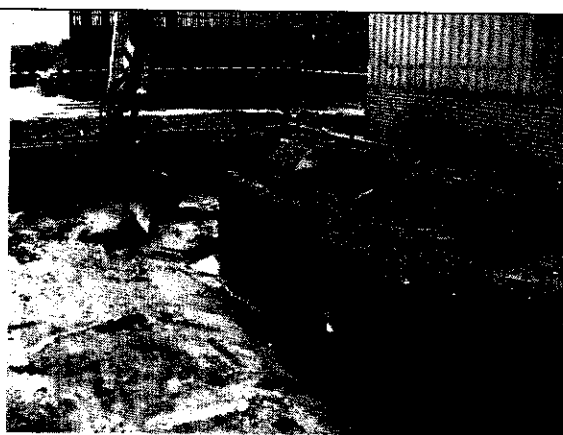
Bovengrond ontgraven tot grondwaterniveau
