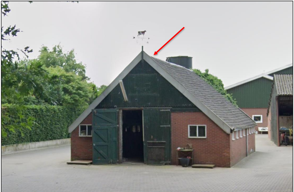
De schuur waar vijf huismusnesten zijn aangetroffen. Met de pijl is grofweg de locatie van de nesten weergegeven, bron: Google Street View.
