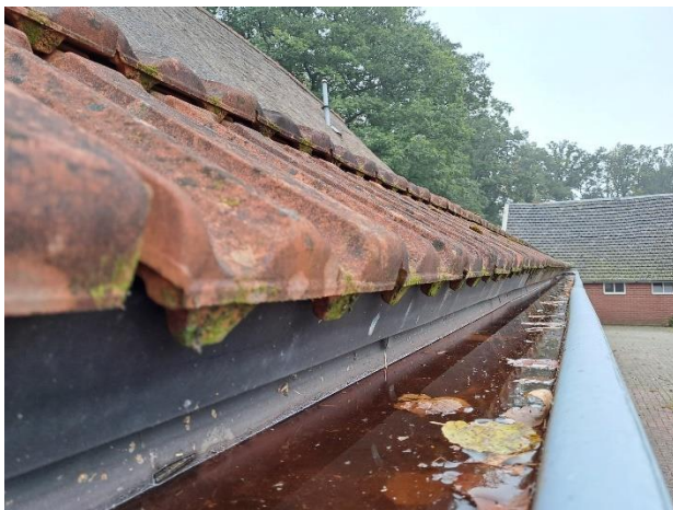
Foto links: faunarasters onder de dakpannen. Foto rechts toont de onderzijde van de dakpannen. Beide foto's betreffen delen van de woning.
