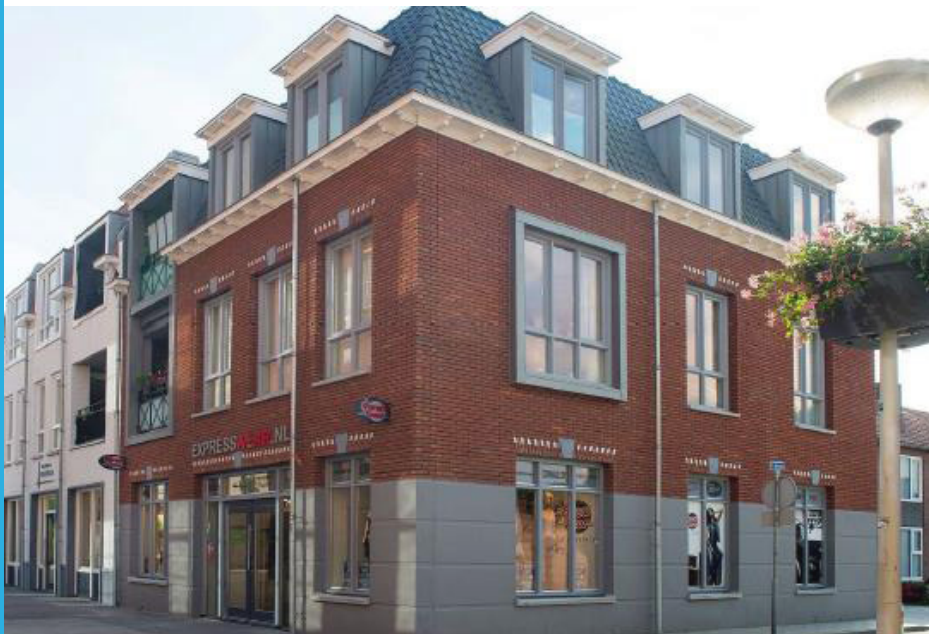
referentiebeeld waarbij de kopgevel als voorgevel is ontworpen
