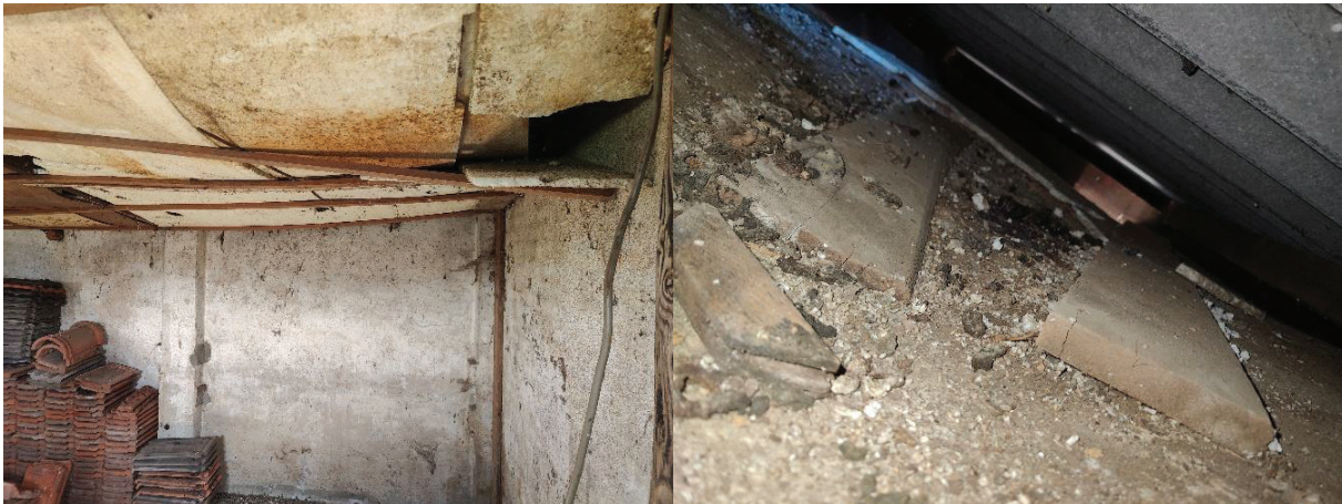
Foto links; Oude isolatieplaten. Foto rechts; Aangetroffen latrine
