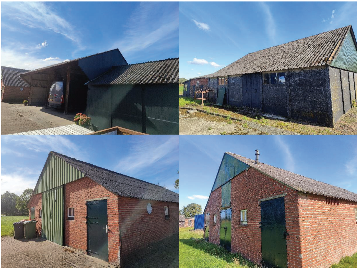
Foto linksboven; kapschuur. Foto rechtsboven; kippenschuur. Foto's onder zuidwestelijke stal met bakstenen buitengevels en luchtspouw.
