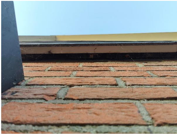
Een smalle opening achter een gevelplank biedt vleermuizen de kans een verblijfplaats te bezetten achter een betimmering.
