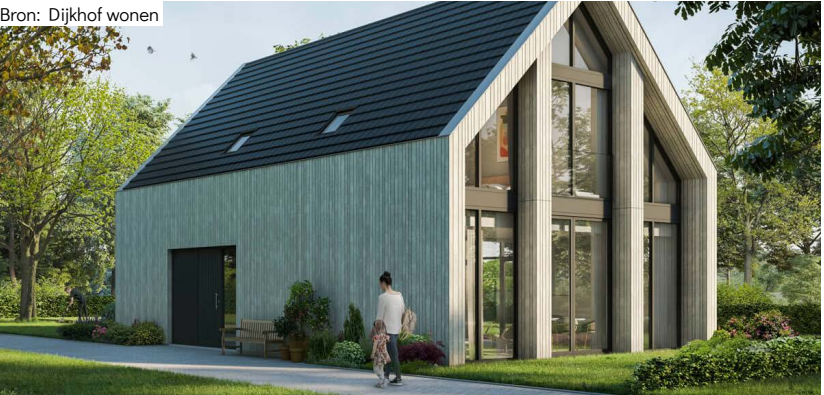
Een meer gesloten zijgevel is wenselijk. Tot de mogelijkheden behoort een verscholen goot zonder dakoverstek aan deze zijgevel.
