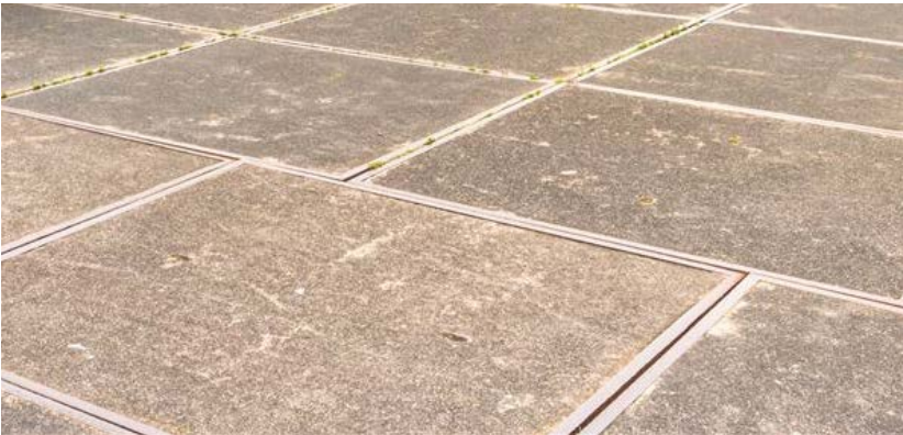
Een voorbeeld van een halfsteensverband met grote betonnen platen.
